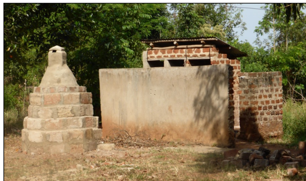
Forbrenningsovnen og latrinen på skolen i Kalagala
